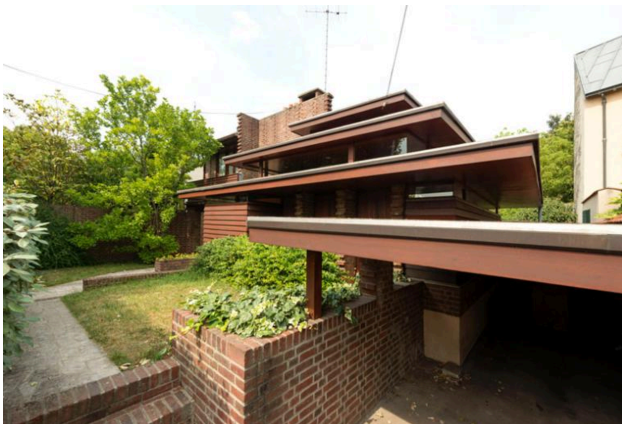
Vue de la façade principale : détail de l'appenti du garage.
