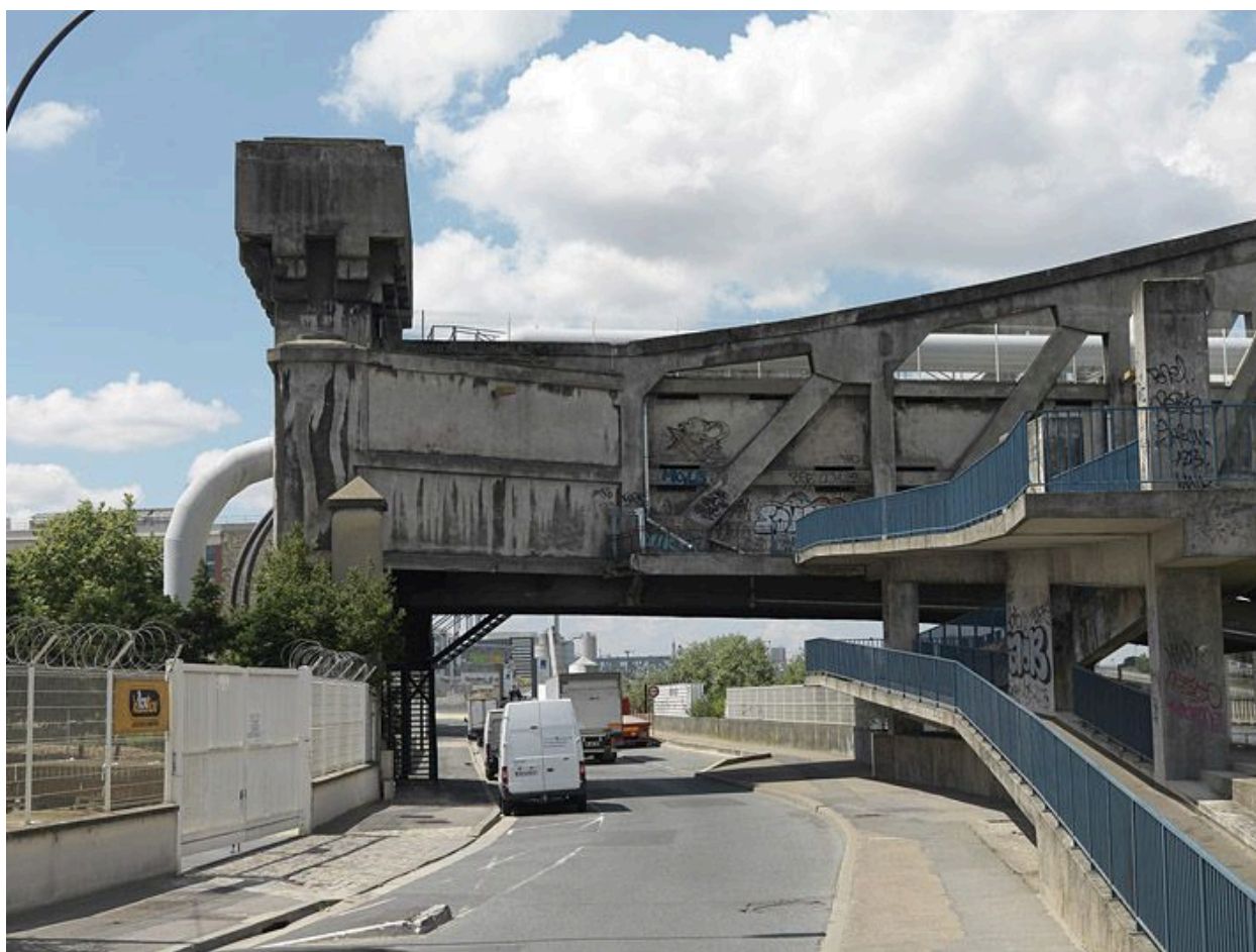
Ivry-sur-Seine, Charenton-le-Pont. Passerelle industrielle d'Ivry-Charenton. Vue du massif d'extrémité côté Ivry.
