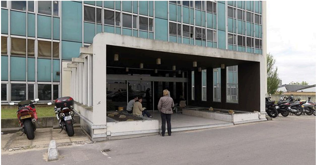
Vitry-sur-Seine, immeuble industriel Burosud, 40-62 rue du Général-Malleret-Joinville. Porte d'accès au bâtiment principal depuis le parking.
