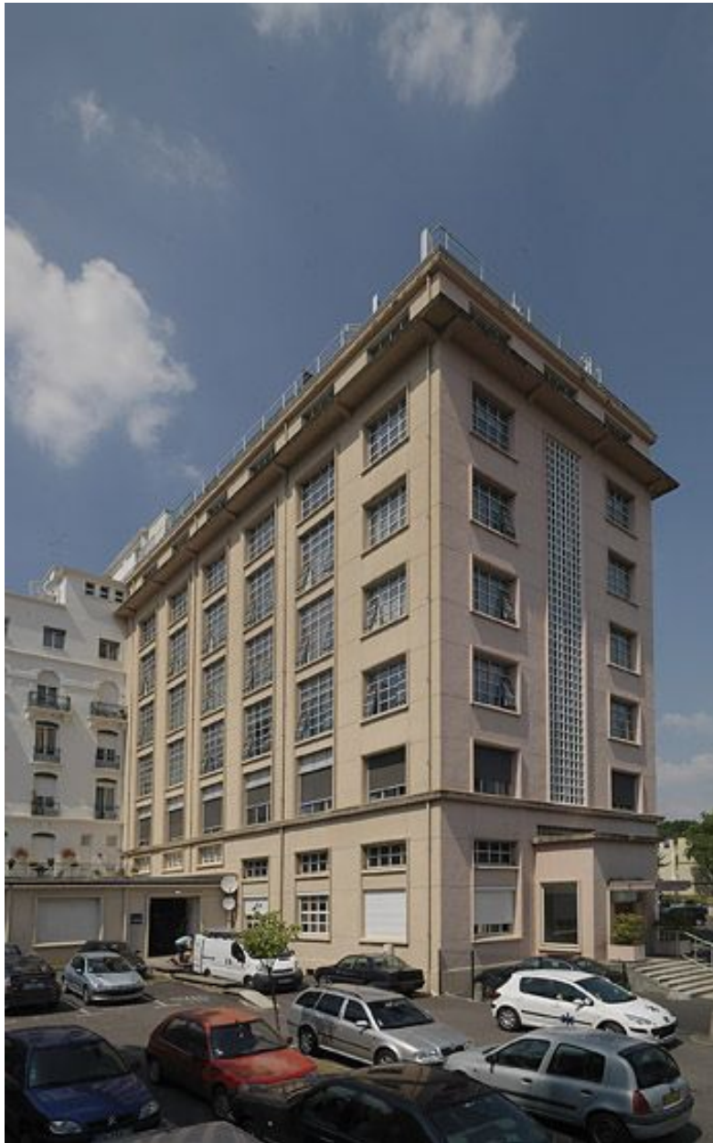
Vue de l'extension PIC, depuis le sud-ouest.
