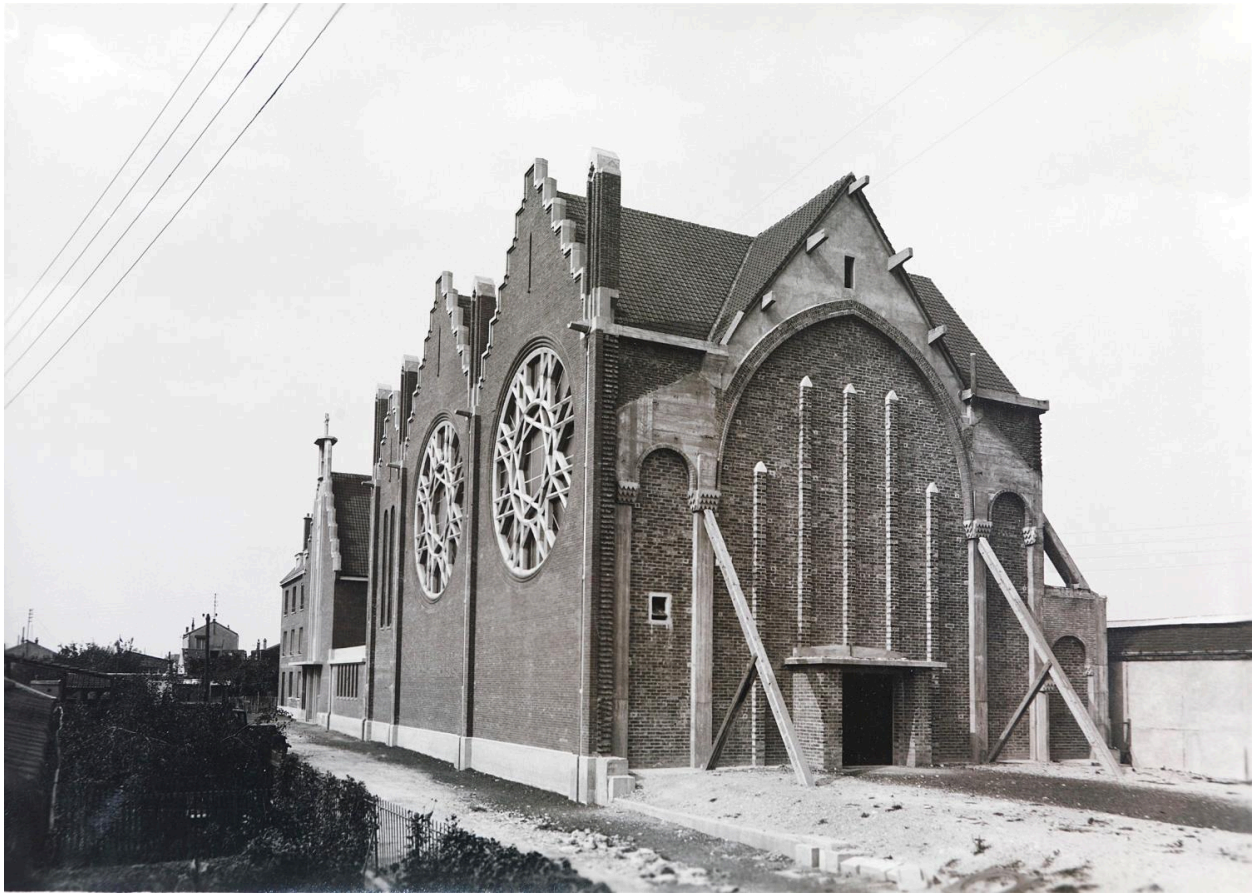
Carte postale ancienne. Eglise Saint-Luc-des-Grands-Champs en construction. Années 1930. (Oeuvre des Chantiers du Cardinal, Paris)
