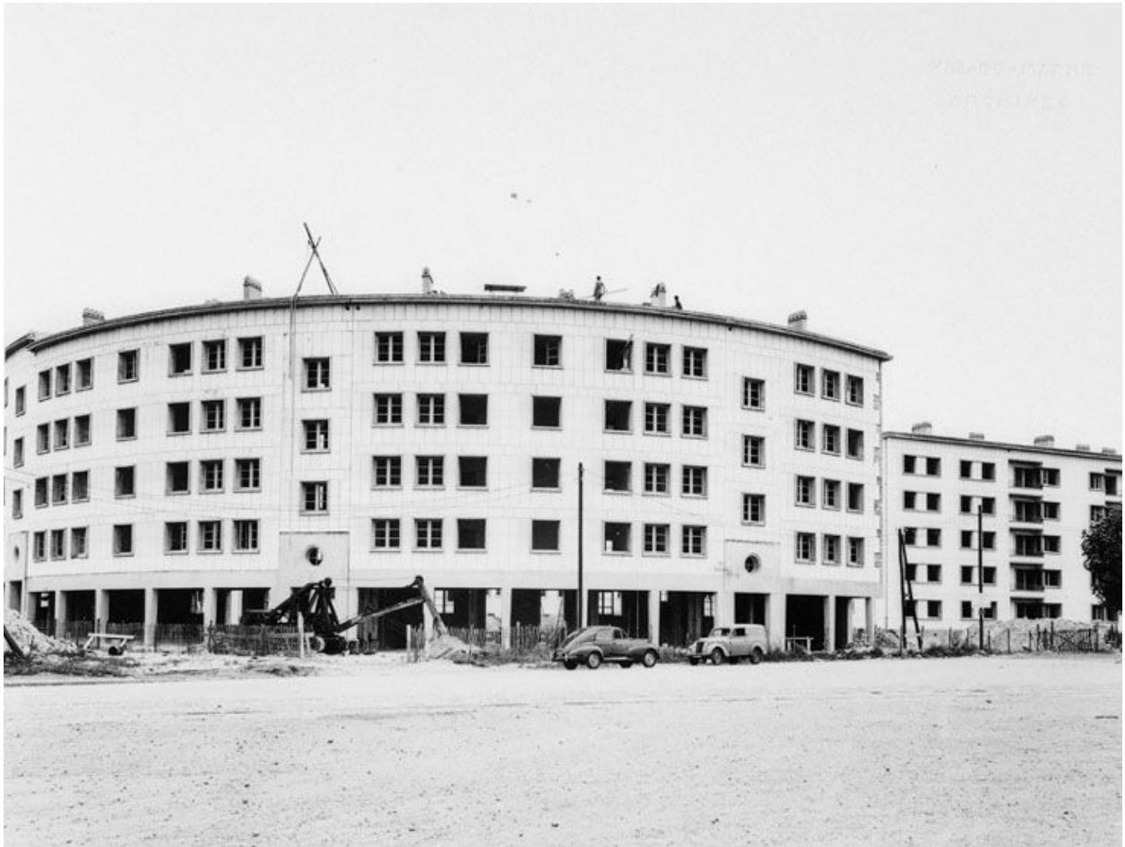
Cité blanche, en construction, avenue de la République et boulevard Jules Guesde. Vue du bâtiment en arc de cercle du côté du boulevard Gabriel-Péri. Paul Pelletier et Michel Feuillas (architectes). Photographie, 1955. (AD Val-de-Marne. 2Fi Champigny 250)
