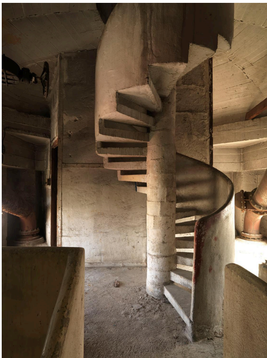
Site Biocitech. Vue de l'escalier du château d'eau.
