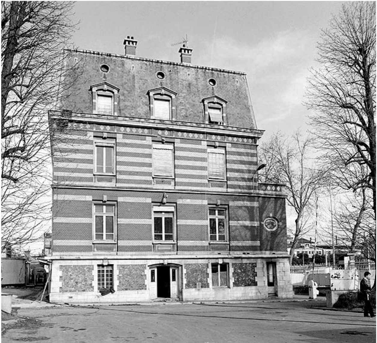
Bâtiment des bureaux : élévation latérale. Photographie avant destruction, 1989. (Ministère de la culture, Inventaire général. 89SG682X)
