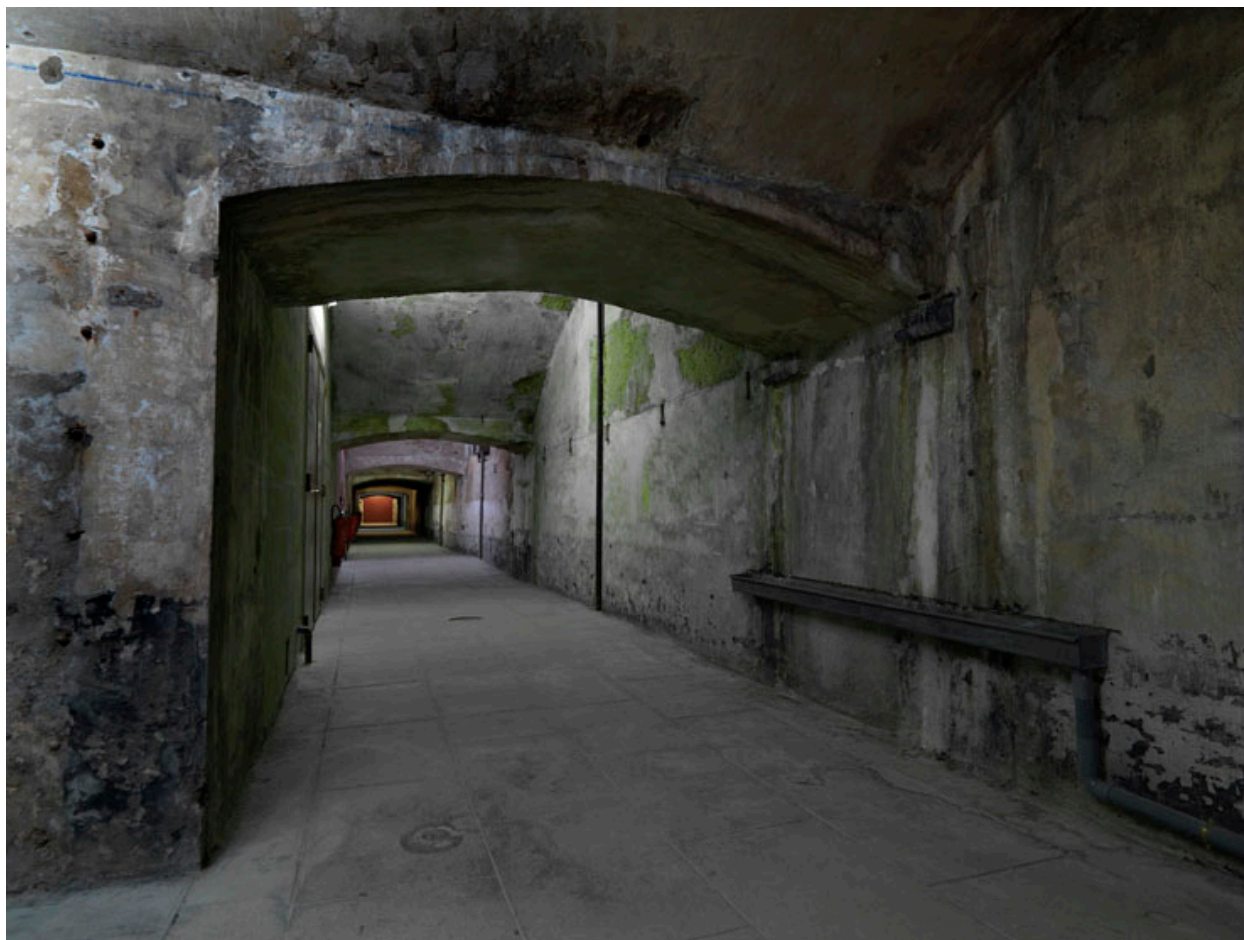
Vue intérieure de la caserne : le couloir du premier étage, vu depuis l'est.
