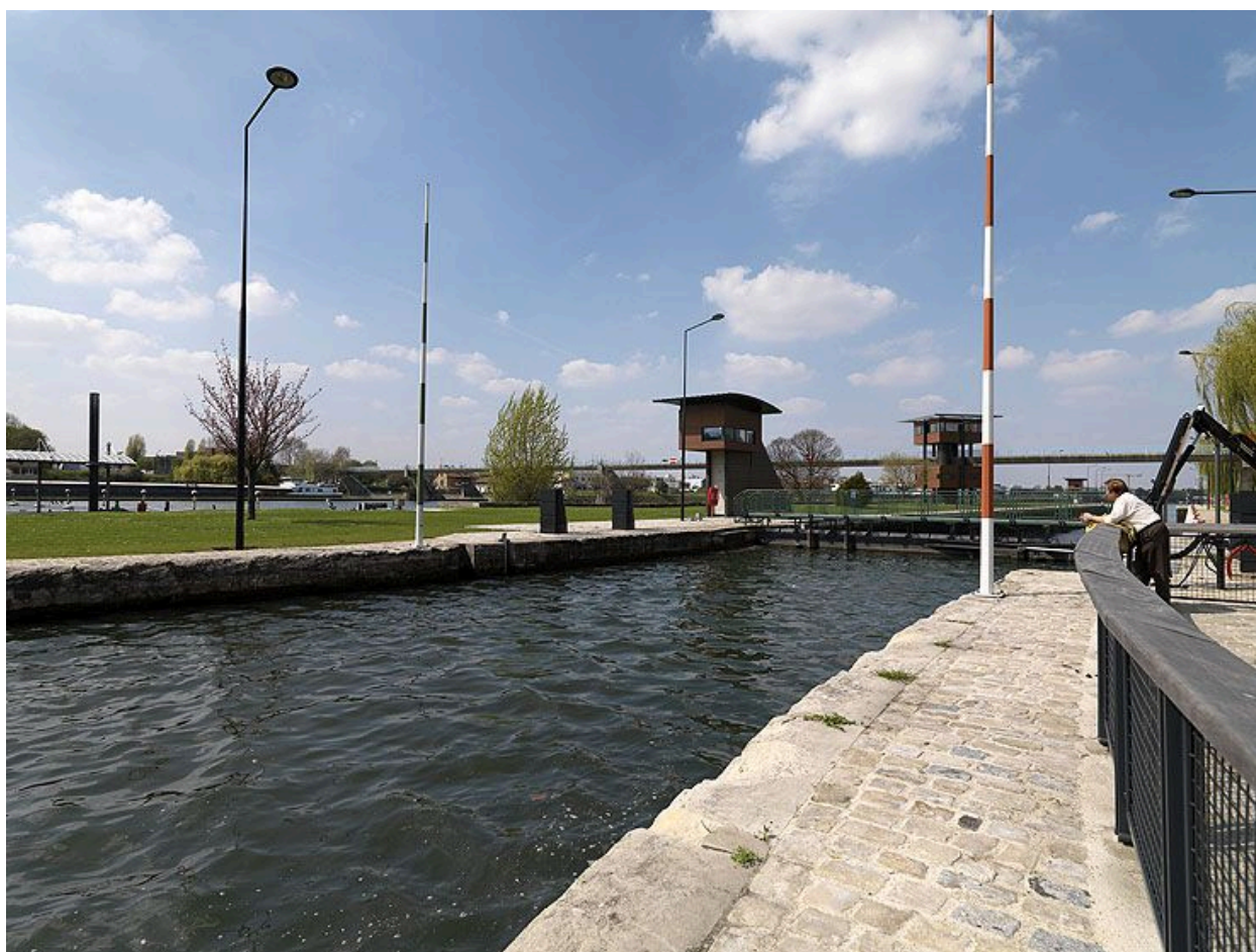
Alfortville, Vitry-sur-Seine. Barrage éclusé de Port-à-l'Anglais. Vue rapprochée de l'écluse et du quai.
