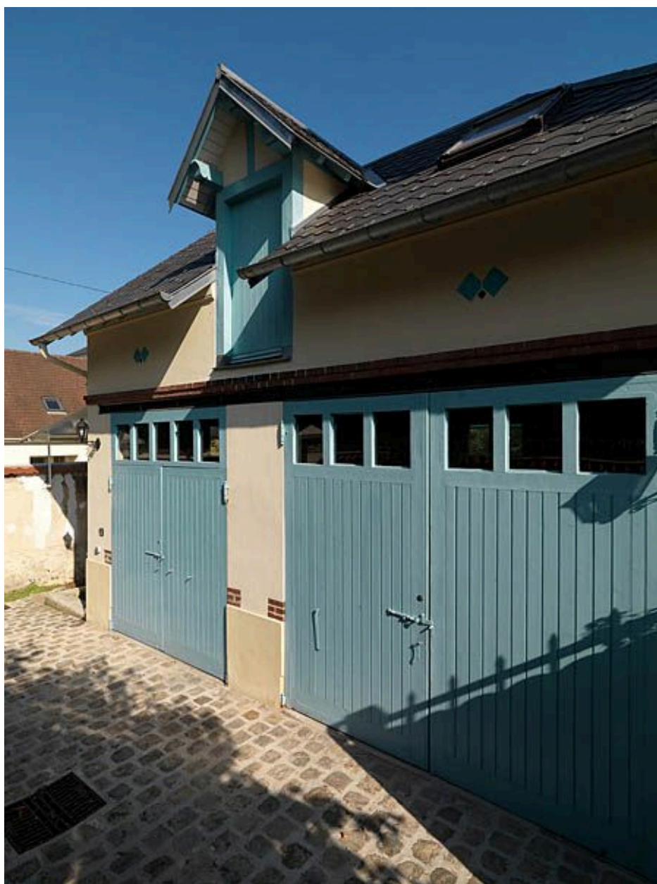
L'écurie, vue depuis le sud-est.
