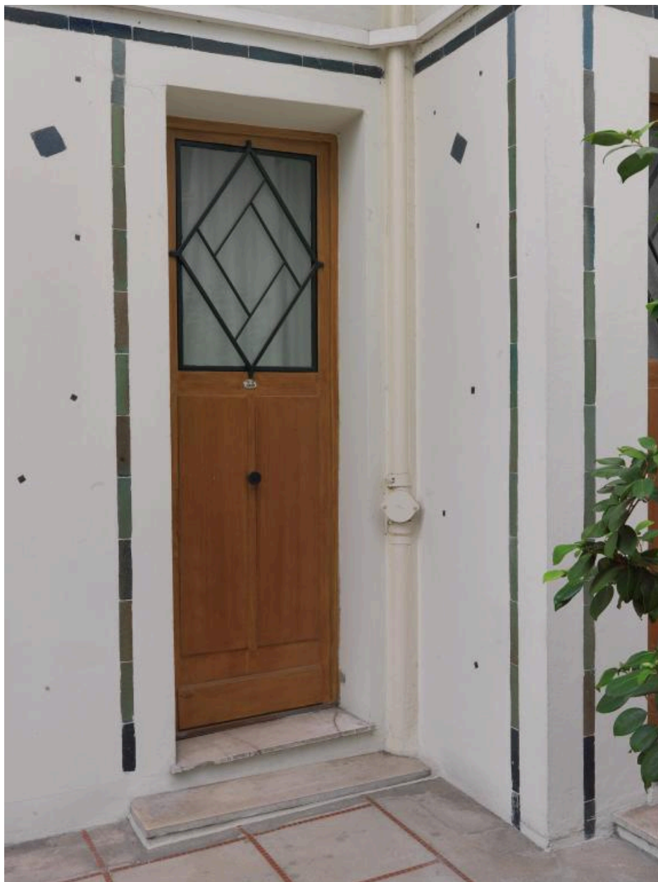
Porte d'entrée d'un des ateliers du bâtiment C
