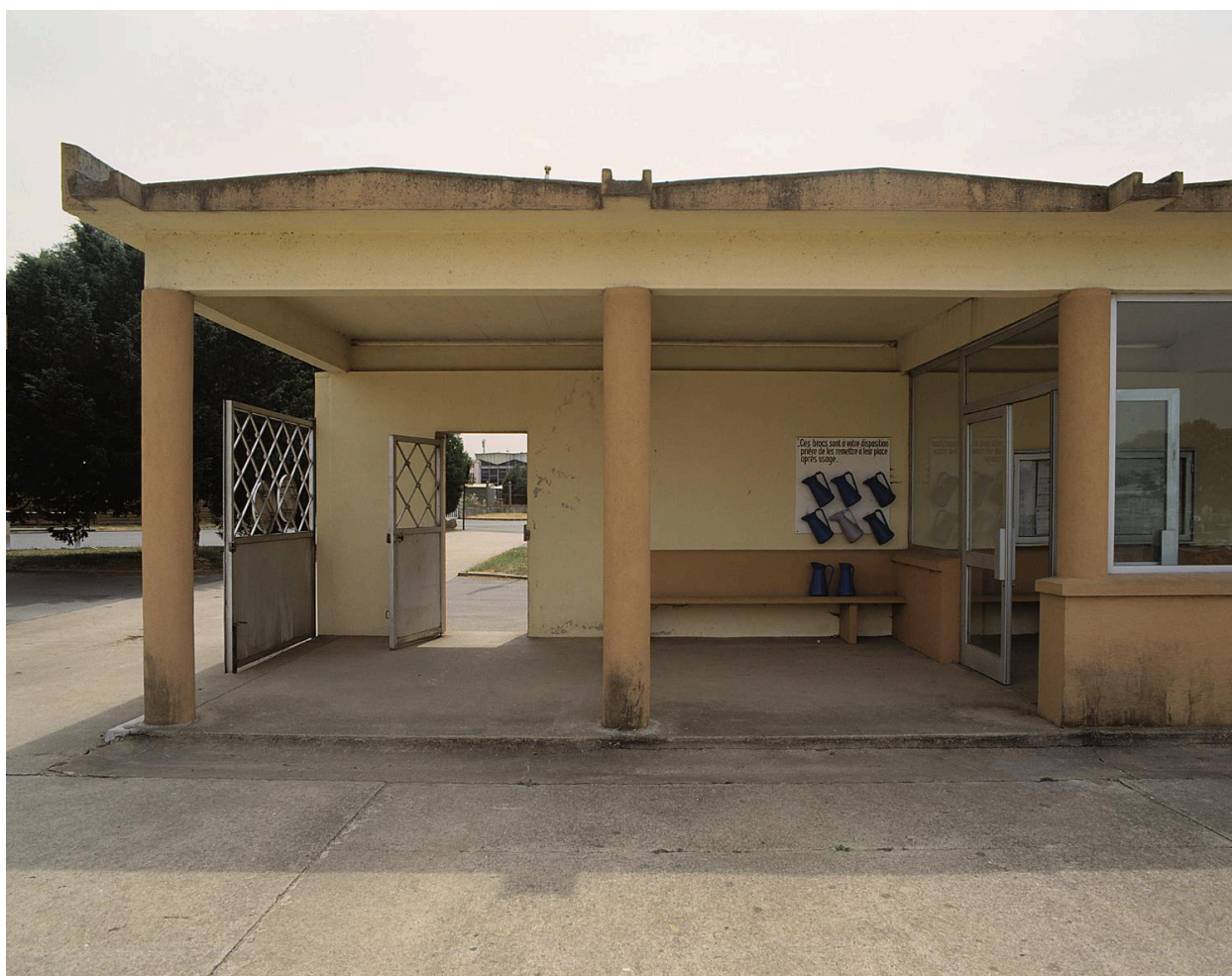
Vue d'un des deux pavillons d'entrée, côté cimetière.
