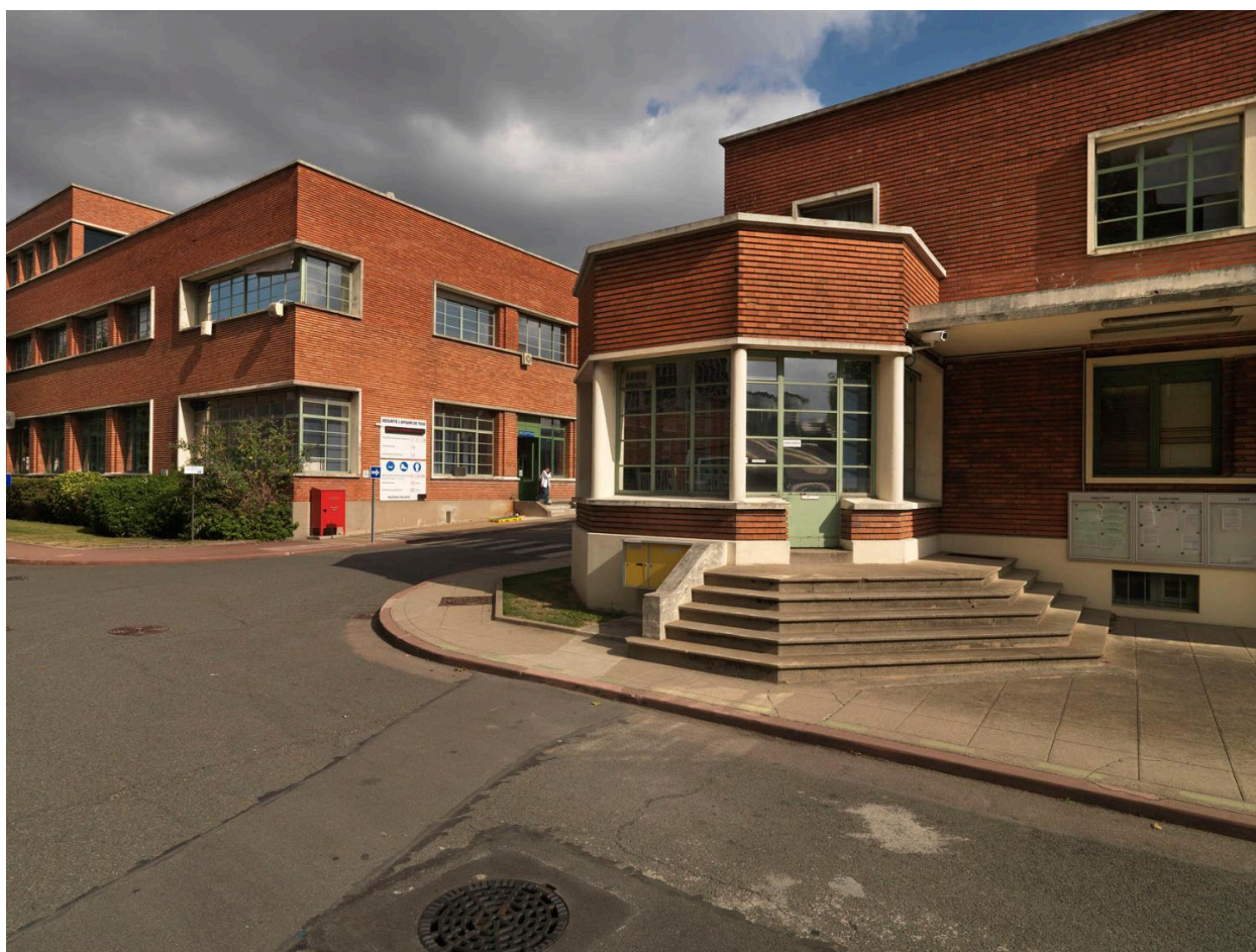
Site Sanofi. Vue du bâtiment d'accueil et du bâtiment de la direction.
