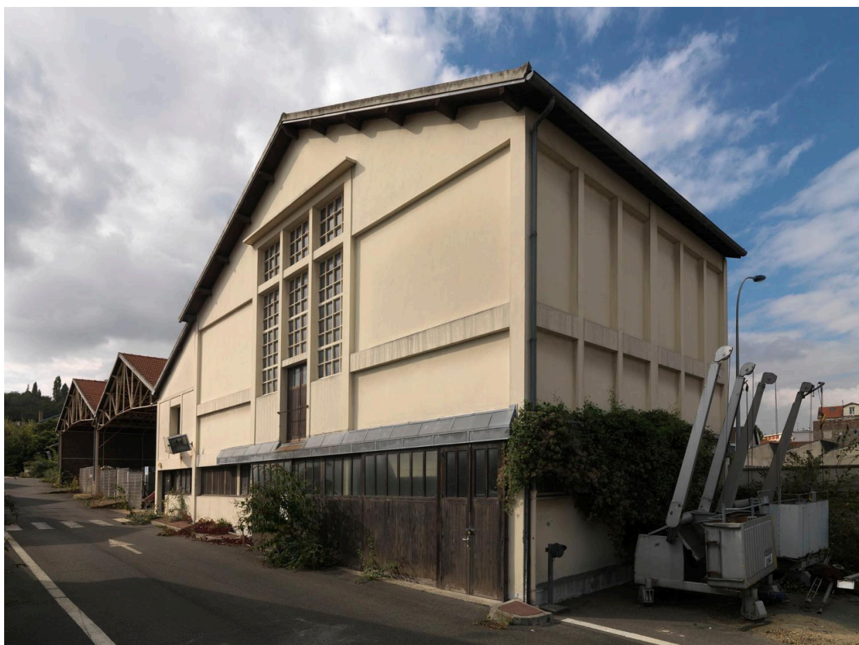
Site Biocitech. Vue des bâtiments désaffectés.
