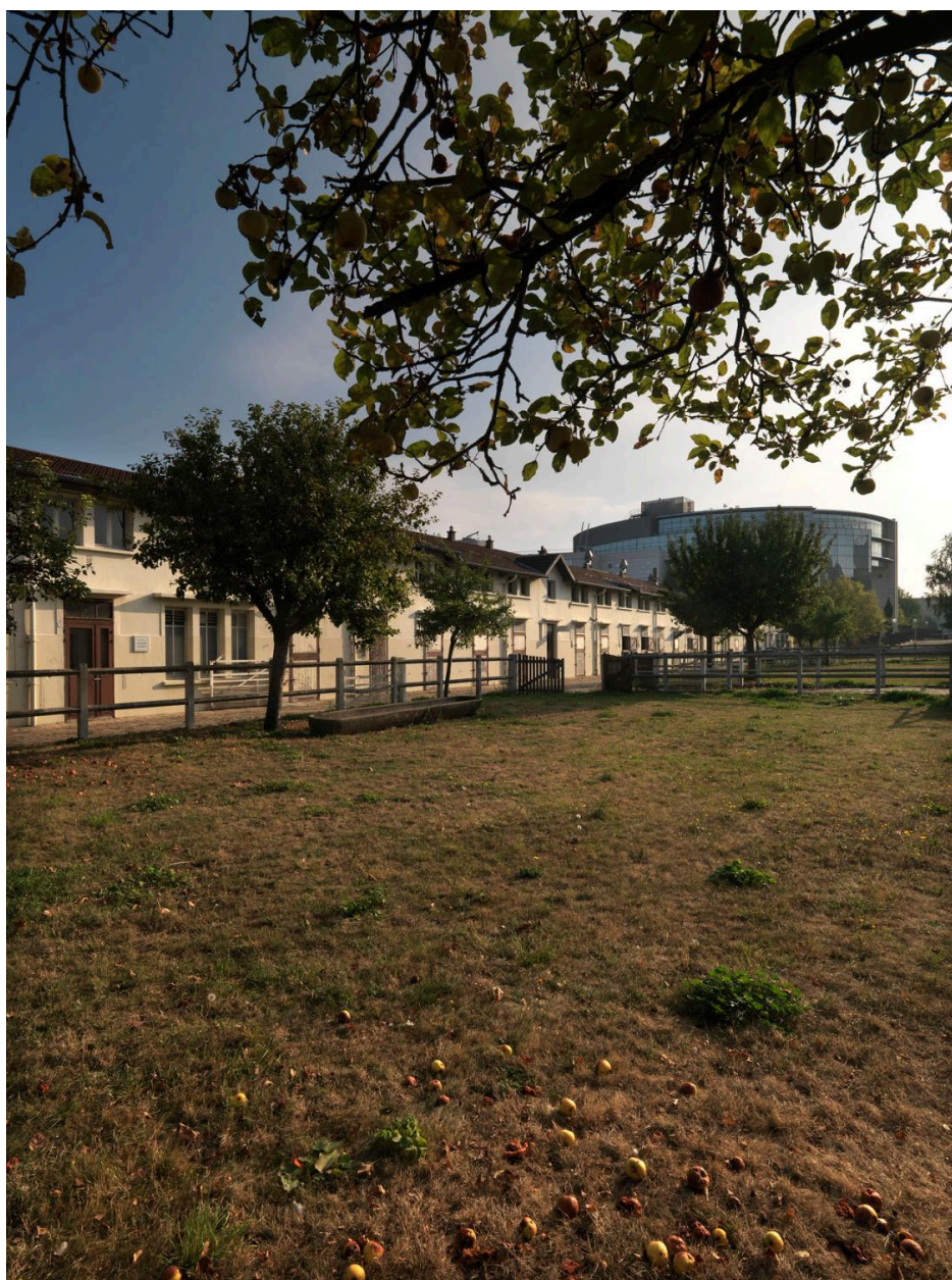
Site Biocitech. Vue des enclos.
