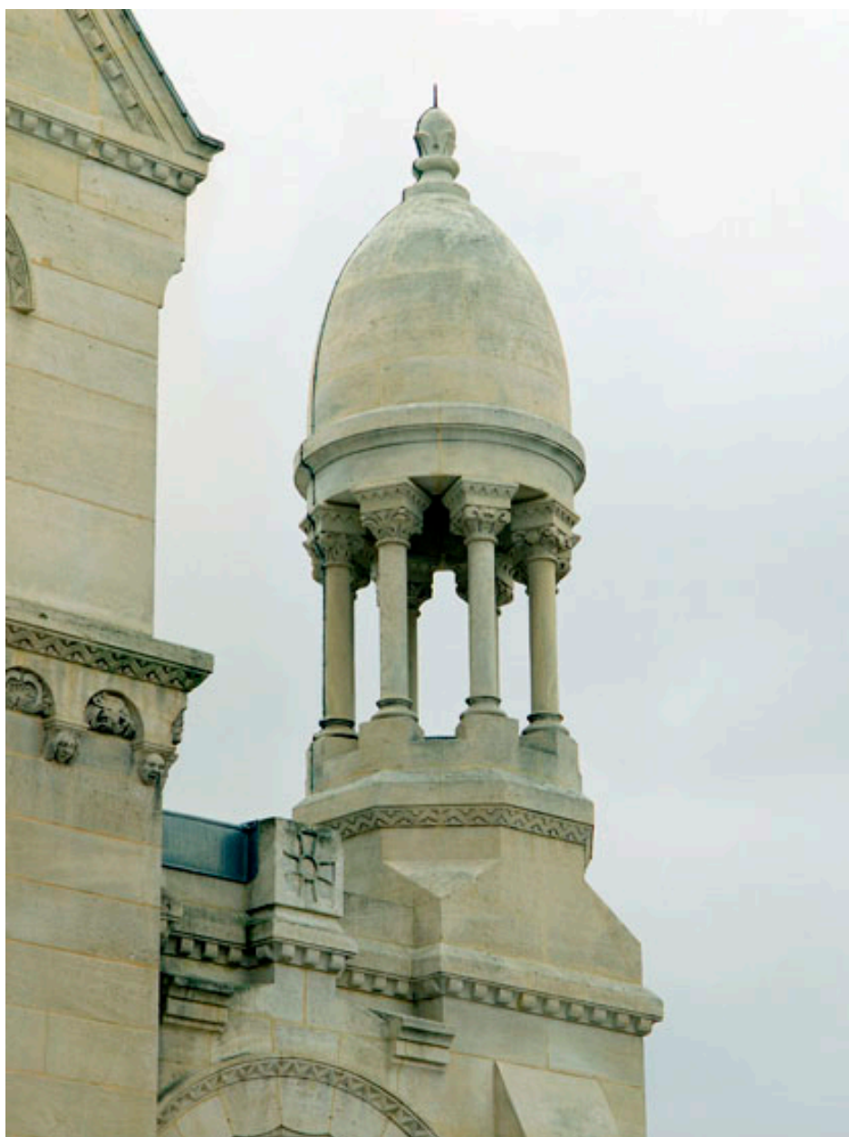
Détail d'un lanternon, à droite de la façade occidental.
