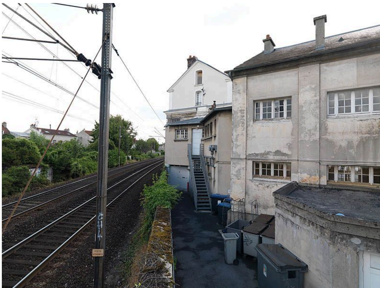
Vue latérale à partir de la voie de chemin de fer.
