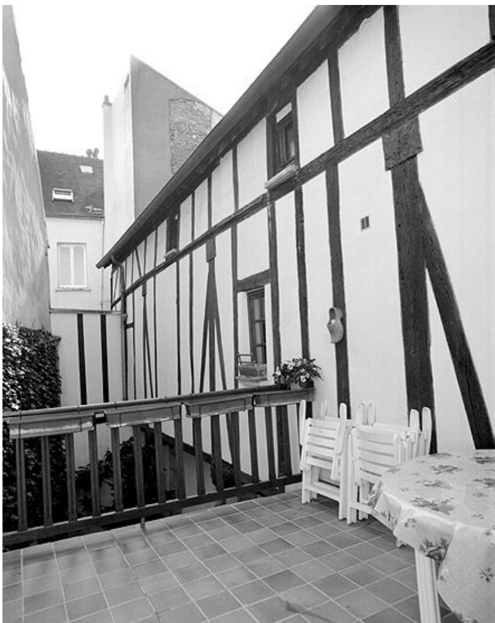
La structure en pan de bois, vue de la terrasse rajoutée au premier étage.
