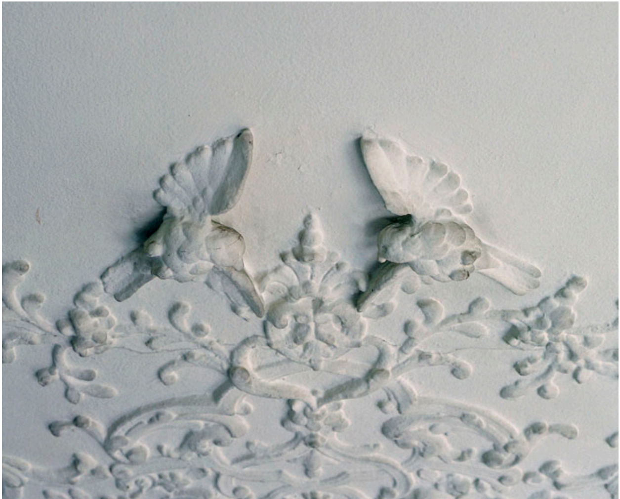
Décor de stuc ornant le milieu du plafond : détail de deux oiseaux volant.
