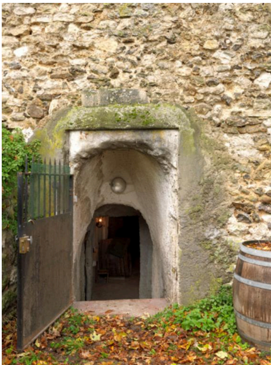
Vue rapprochée de l'entrée du cellier.
