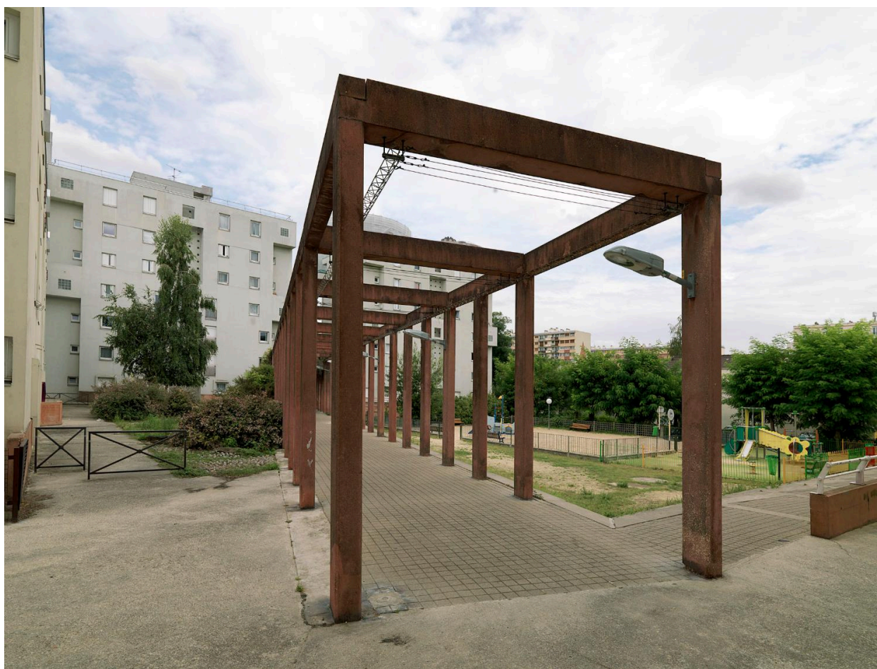
Cité Pablo Neruda. Vue rapprochée du portique extérieur.
