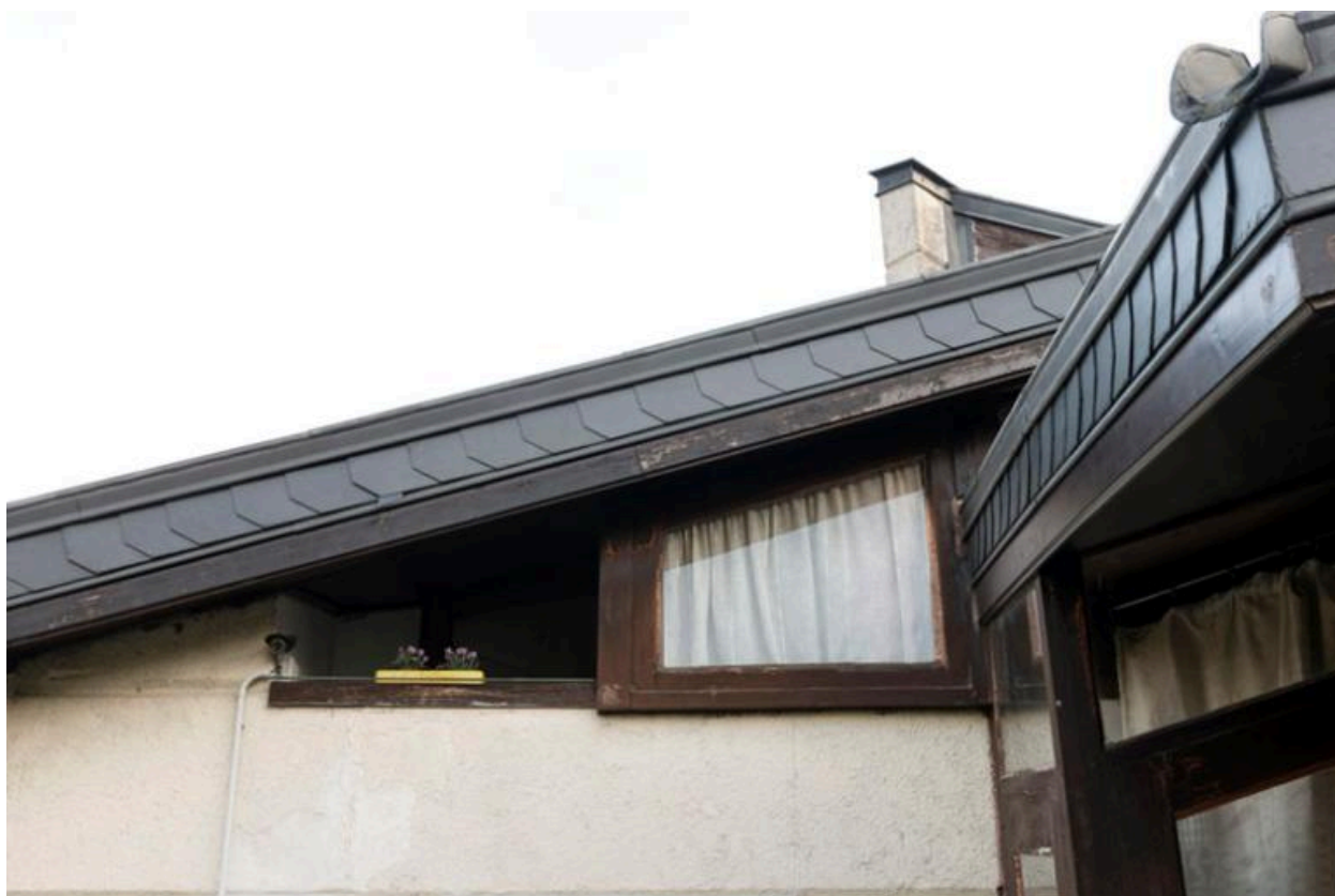
Détail du toit et d'une fenêtre côté jardin.
