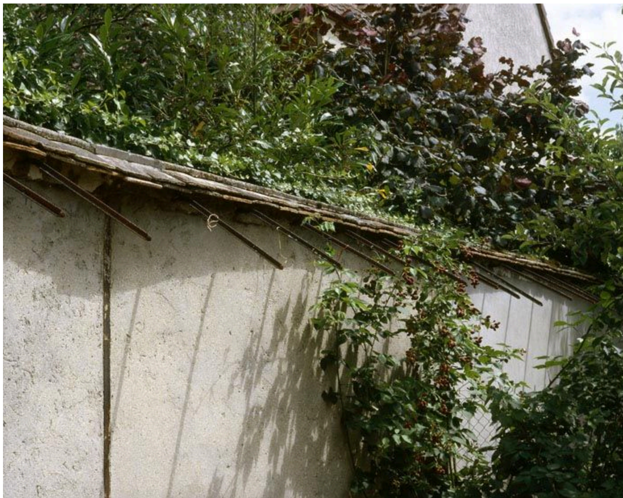
Maurecourt. Anciens murs à chasselas, 17 rue de la Gare.
