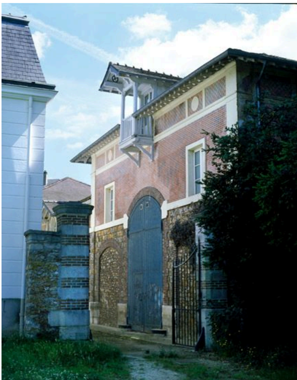
Un bâtiment des communs à l'ouest du château.
