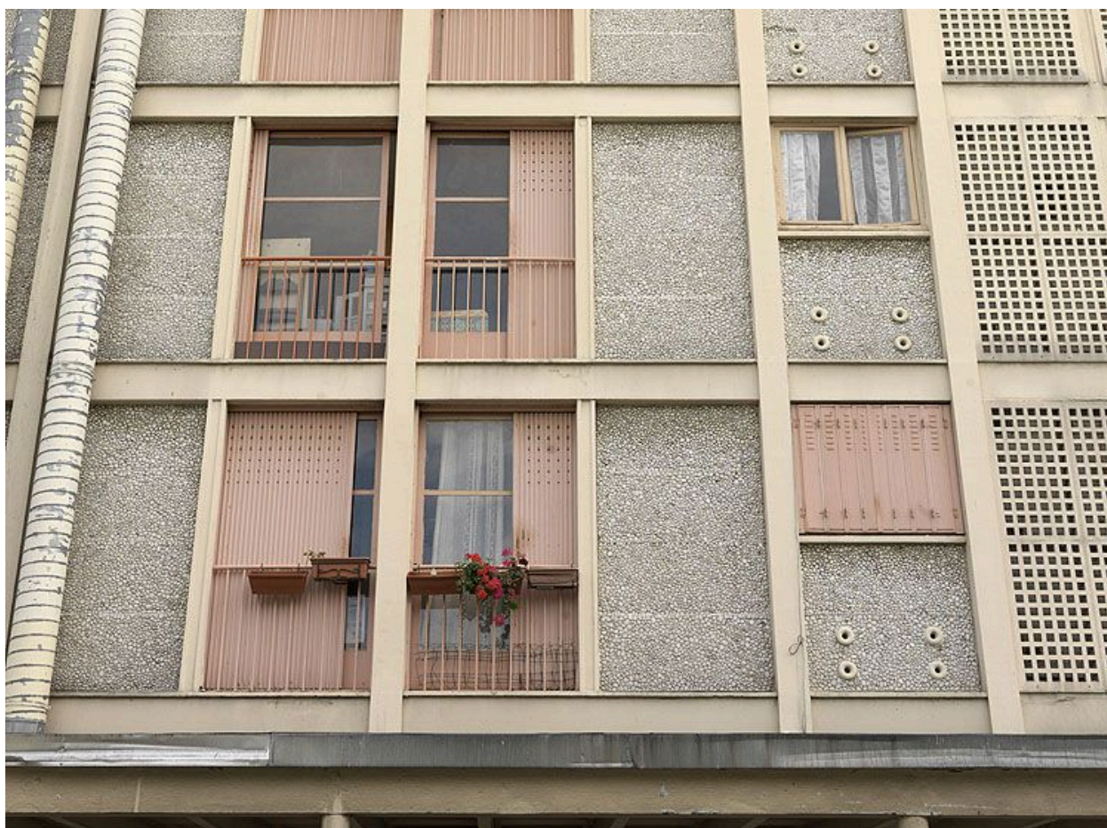
Détail de la façade avant travaux, avec les huisseries de J. Prouvé encore en place.
