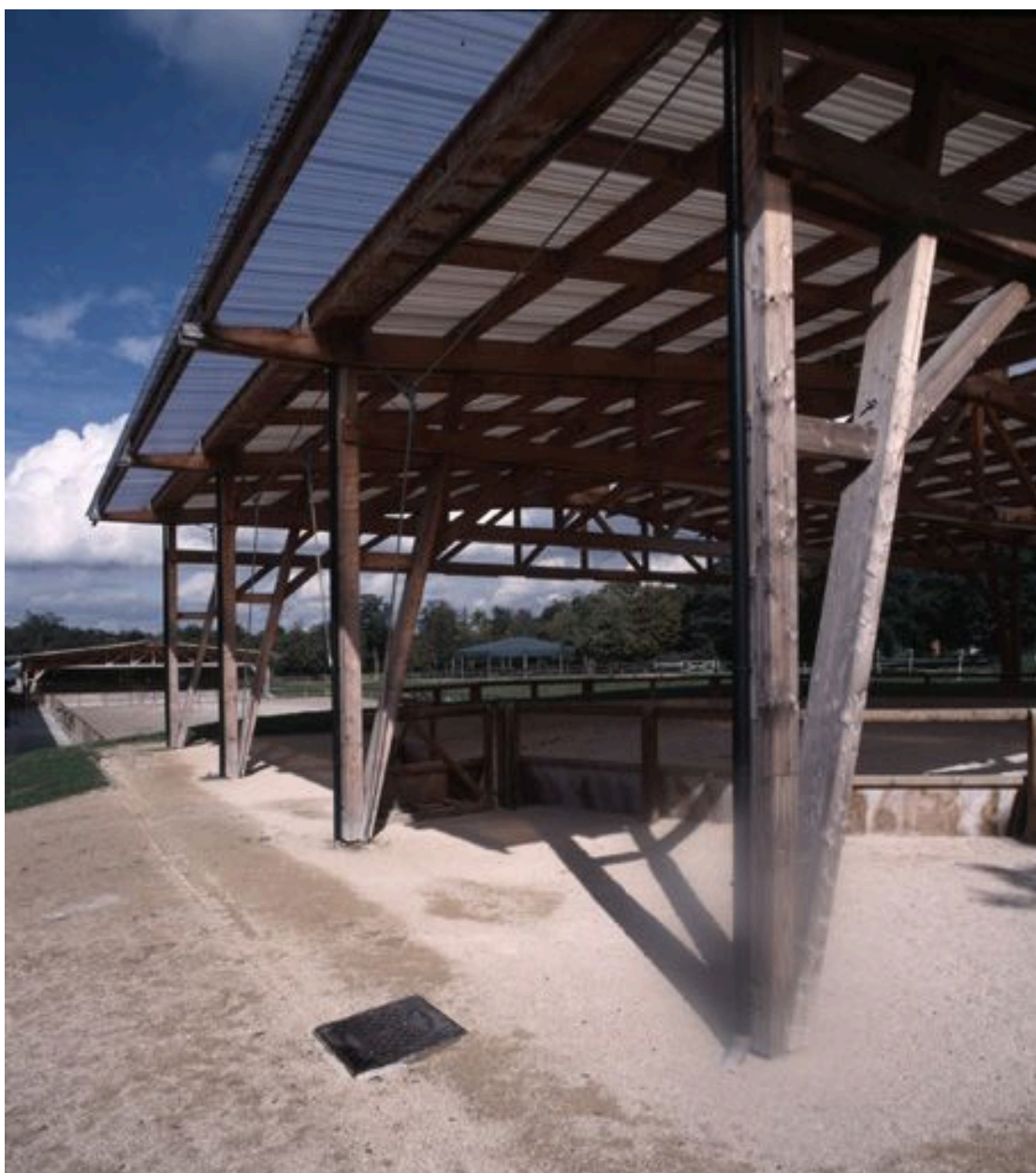
Détail de la couverture du manège.
