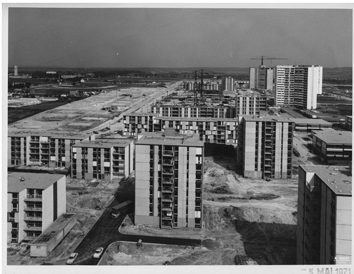
Chantier de la construction de Beauval A vu depuis la tour Albret, avec barres tours et école le long du mail des Alobroges. . 12 janvier 1971. (OPAC Meaux)
