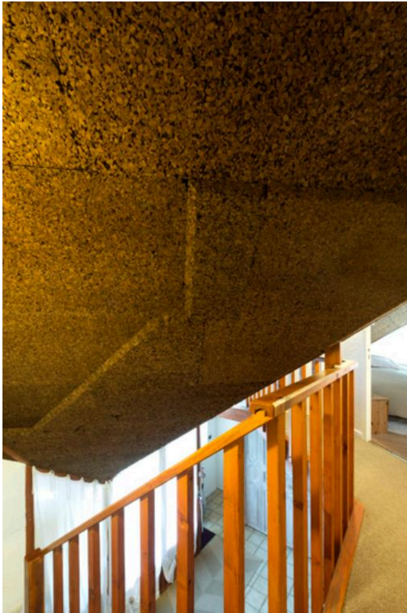
Vue prise depuis la mezzanine du 1er étage.
