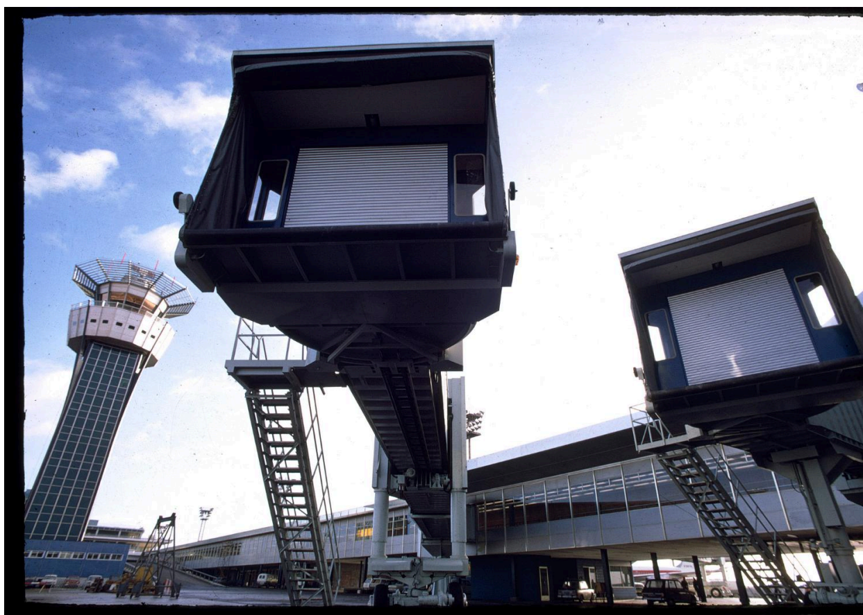
06/1970, les premières passerelles d'embarquement de l'aéroport d'Orly
