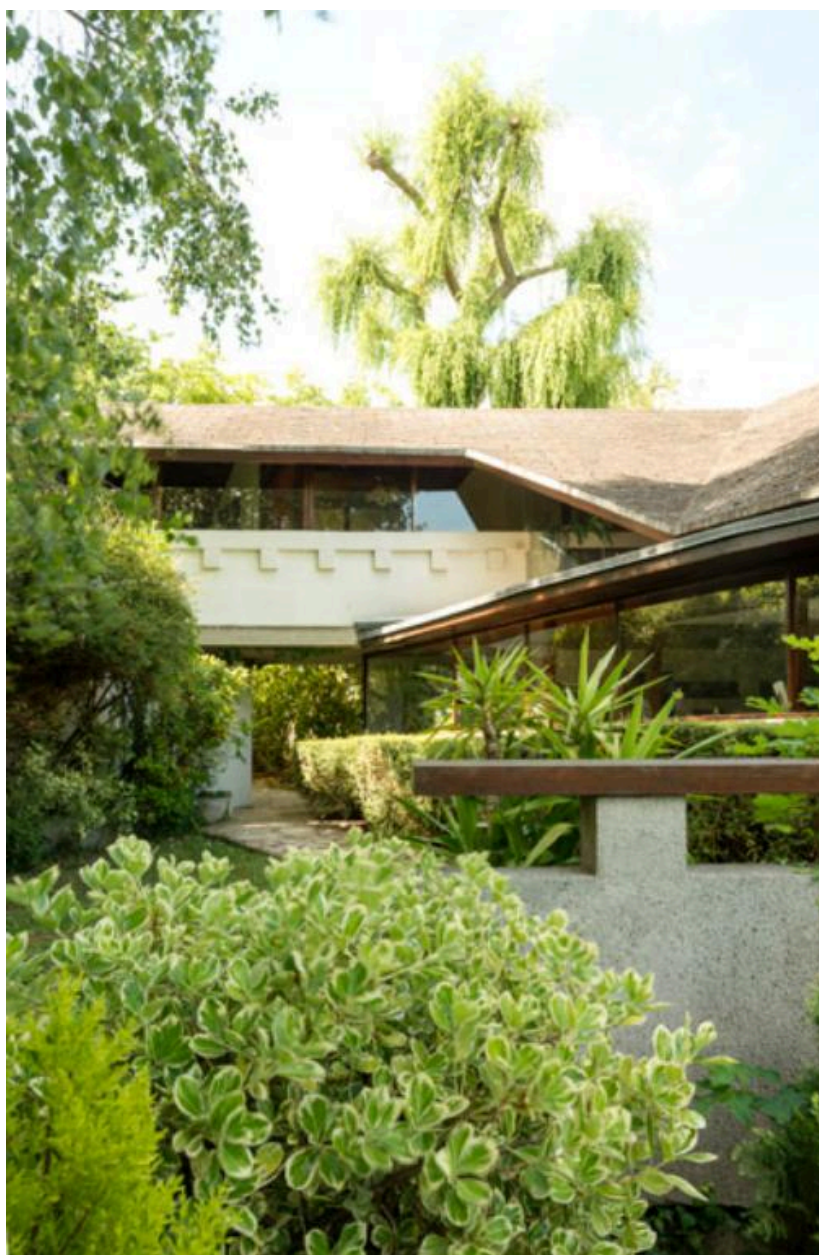
Vue de la passerelle reliant l'aile principale et l'aile secondaire.
