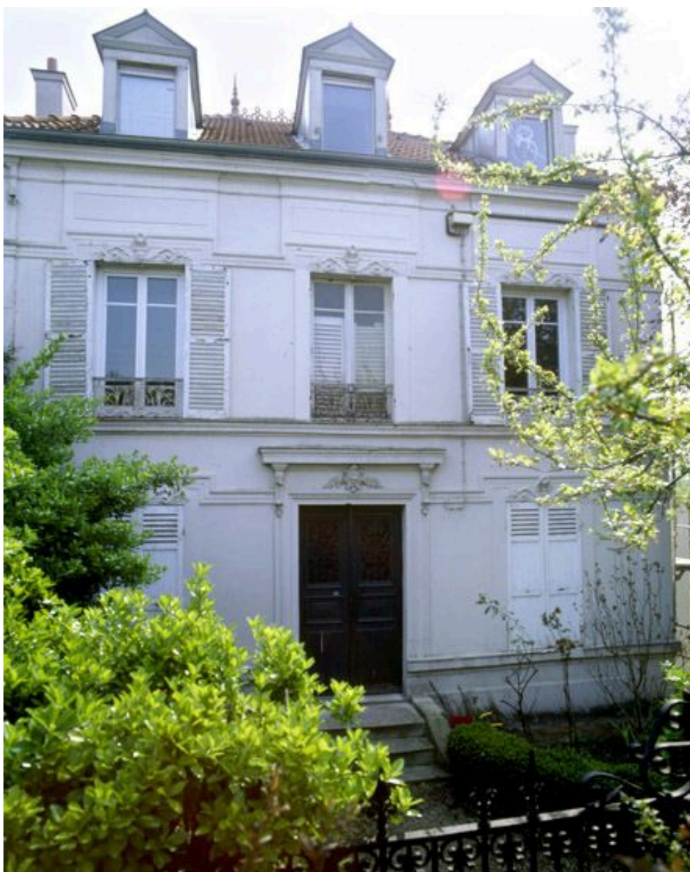
Maison, 4 rue Arthur Adamov. Vue d'ensemble de la maison.
