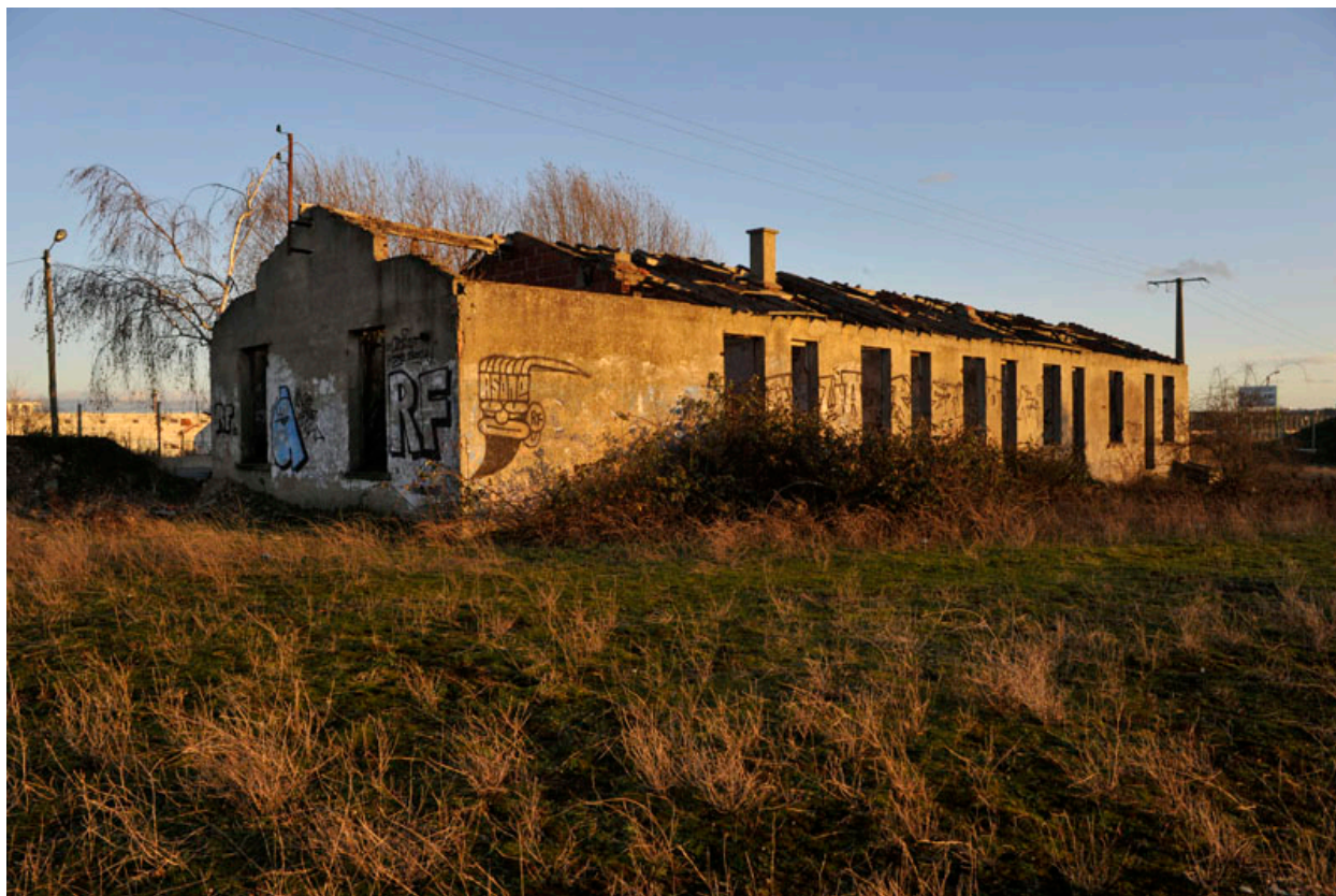
Triel-sur-Seine, carrière (sablère et gravière) Lafarge Granulats, 2 chemin des Gravieres. Ruine d'un ancien bâtiment d'exploitation.
