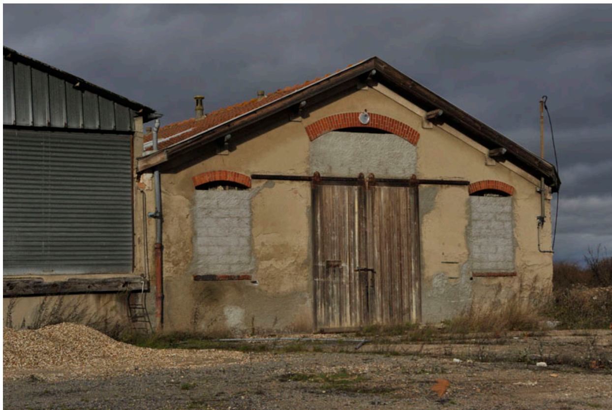
Achères, entrepôt agricole, chemin des Hautes-Plaines. Vue du bâtiment ancien.
