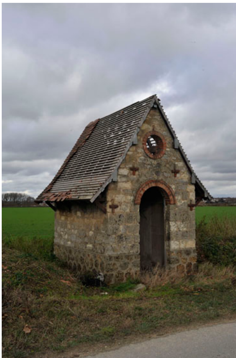
Achères : abri de cantonnier
