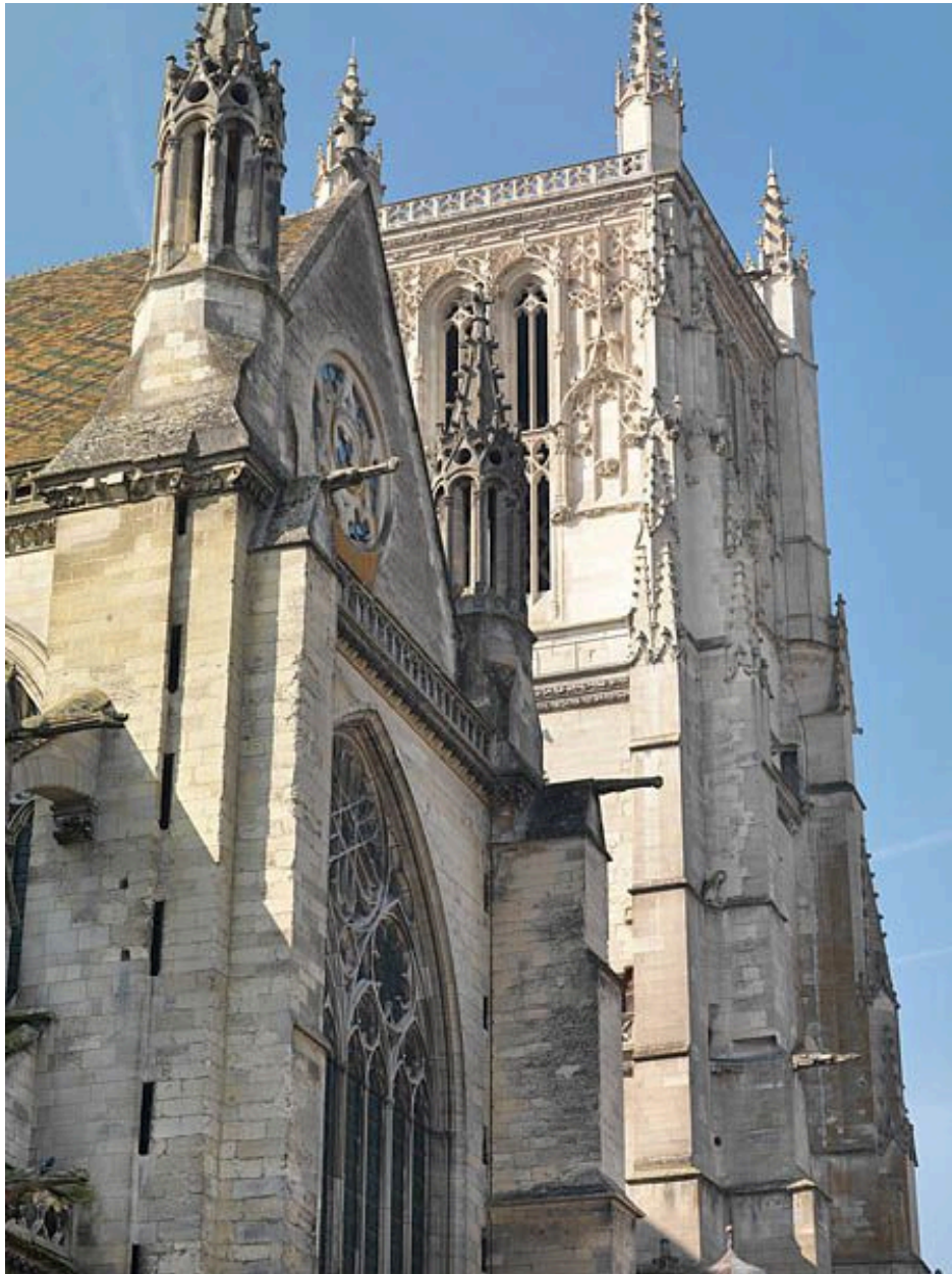
Détail des parties supérieures, côté nord : pignon du transept et sommet de la tour nord.
