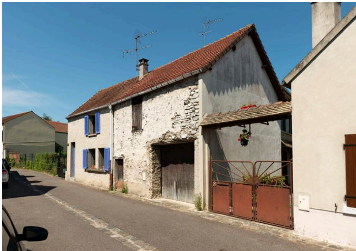
Anciennes maisons rurales rue Marceau.
