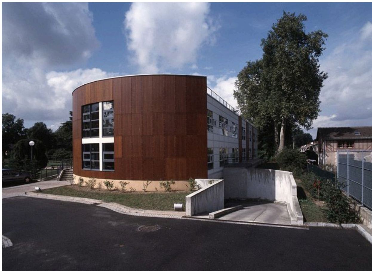
Vue latérale de la Maison des Solidarités, construite par le conseil général de l'Essonne en 2002-2003.
