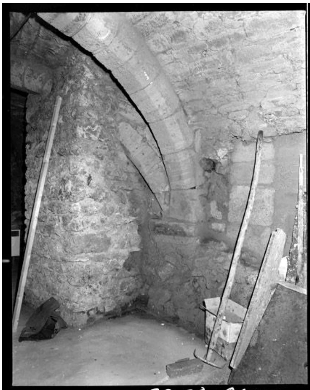
Maison, Chanzy (rue de) 1. Détail de l'ogive de l'une des caves.
