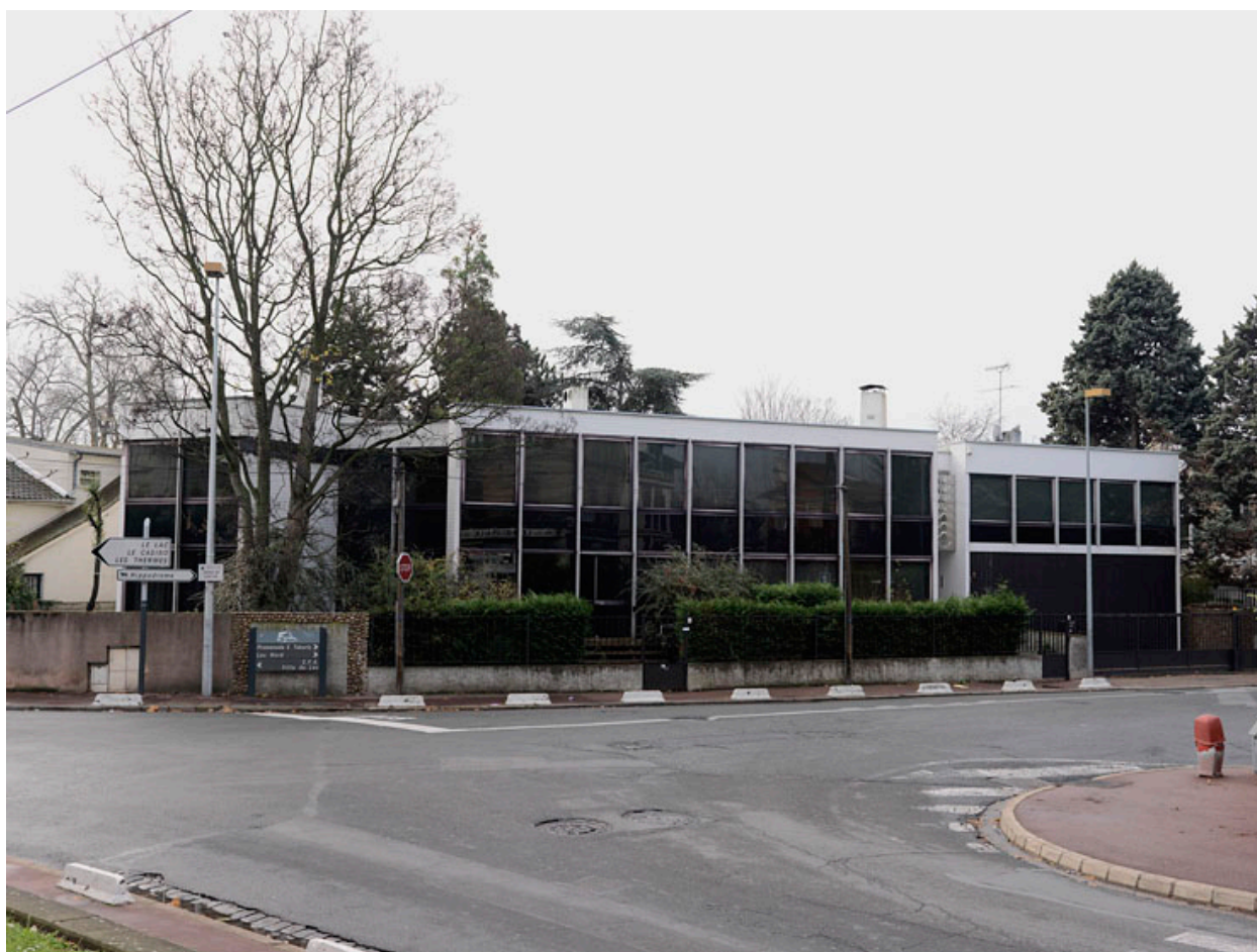
Vue d'ensemble depuis la rue.
