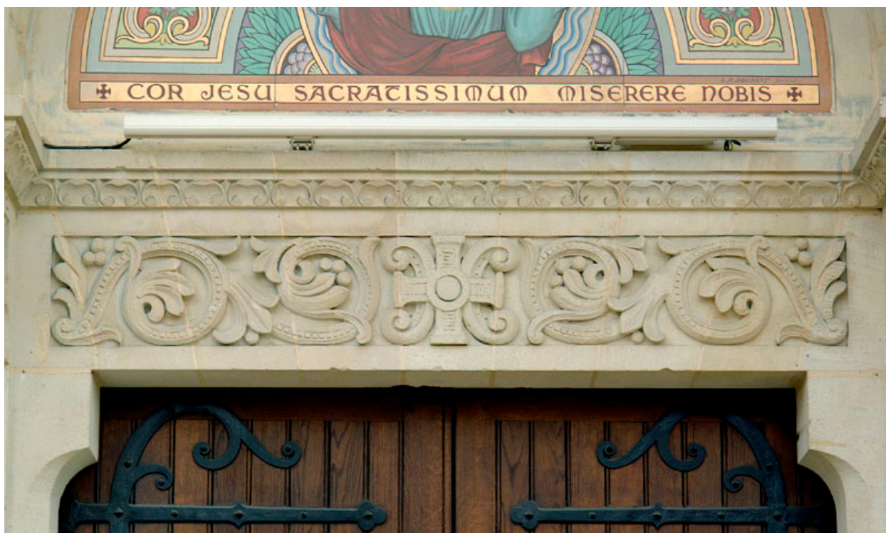
Façade occidentale : détail du linteau sculpté au dessus de l'entrée principale.
