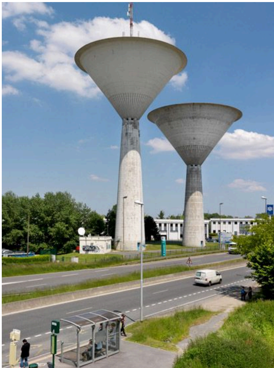
Villebon-sur-Yvette, route Départementale 118. Vue des châteaux d'eau.
