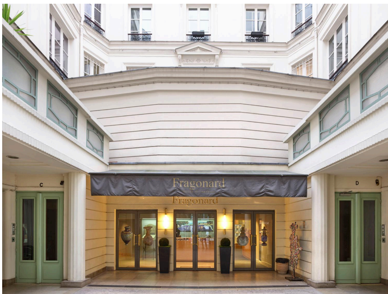
Façade sur cour intérieure
