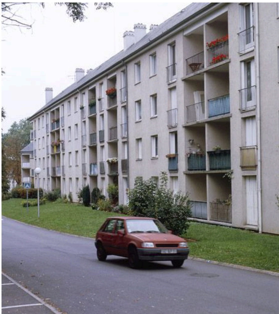
Façade sur rue de l'immeuble n° 62 à 68.
