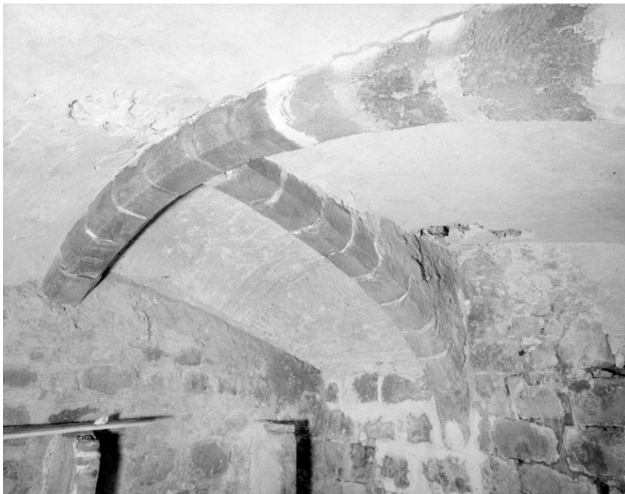
Partie sud de la cave, voûtée en berceau avec arcs doubleaux. Détail des arcs.
