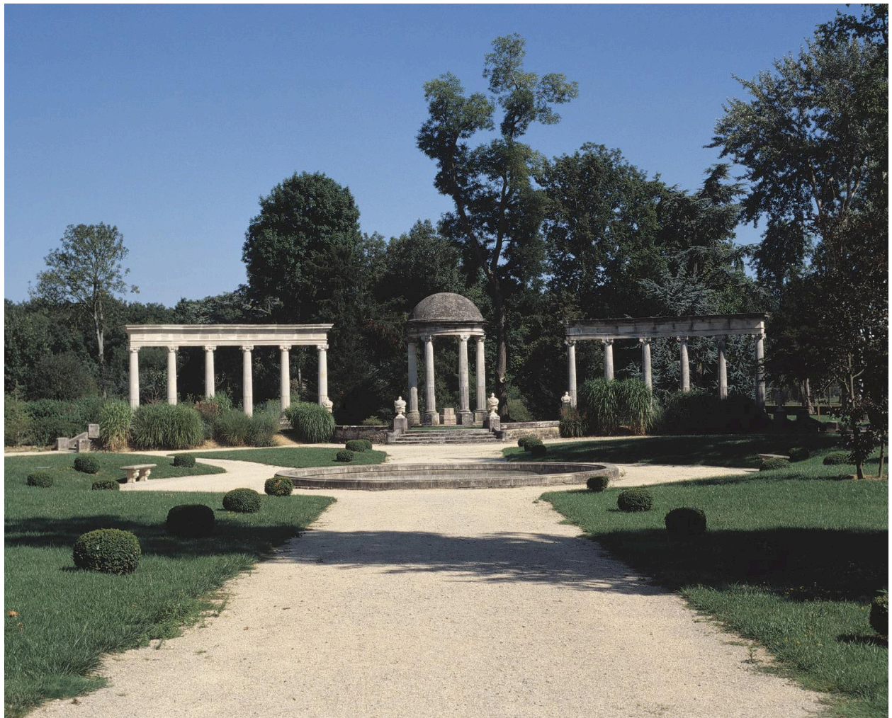
Vue perspective vers l'exèdre après sa restauration.
