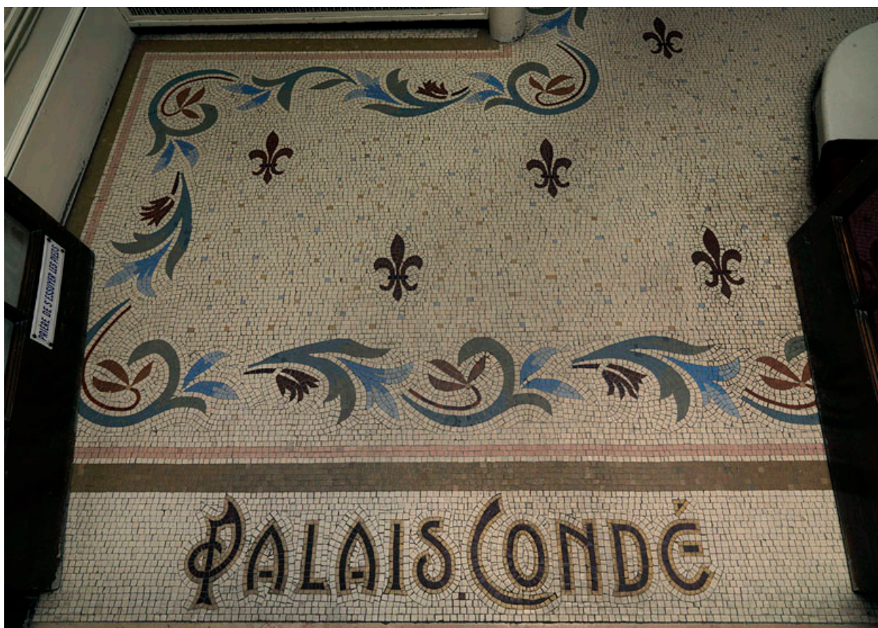
Détail de la mosaïque du pavement de l'entrée de l'immeuble.
