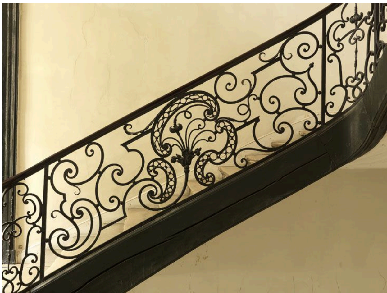
Escalier principal : le premier panneau rampant.
