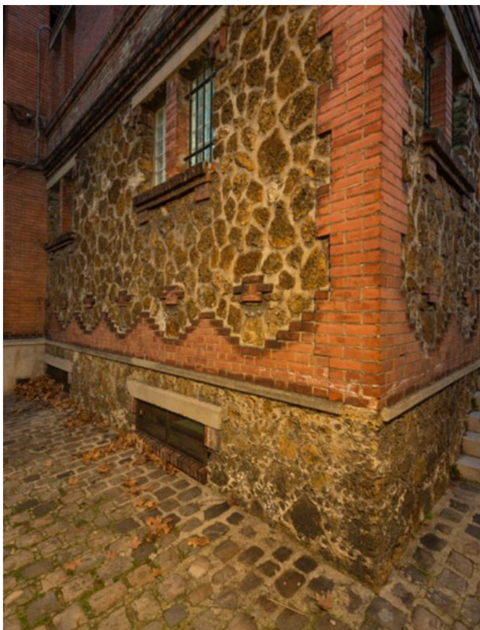
Détail du soubassement en pierre meulière et des chaînages d'angle en brique rouge.
