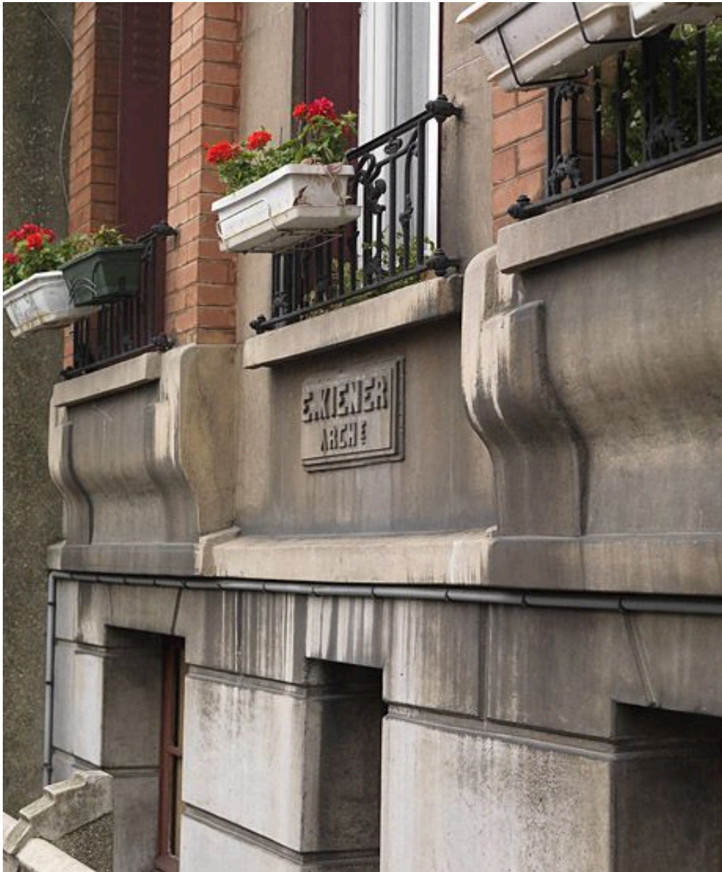
Vitry-sur-Seine, immeuble, 15 rue des Ardoines. Détail de la plaque de l'architecte E. Kiener et d'un balcon .
